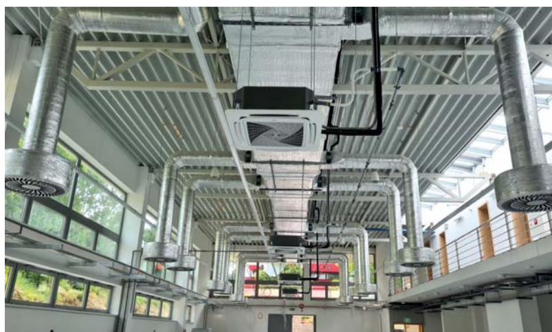
Odvetrávanie a chladenie v hale.
