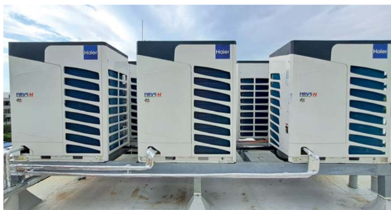
Súbor moderných vonkajších jednotiek Haier MRV systému.
