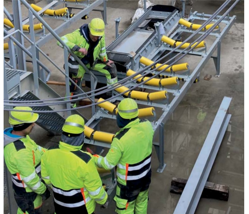
Montéři divize Těžká vzduchotechnika měli pracovní oděv s vysokou viditelností hi-vis a retroreflexními prvky.
