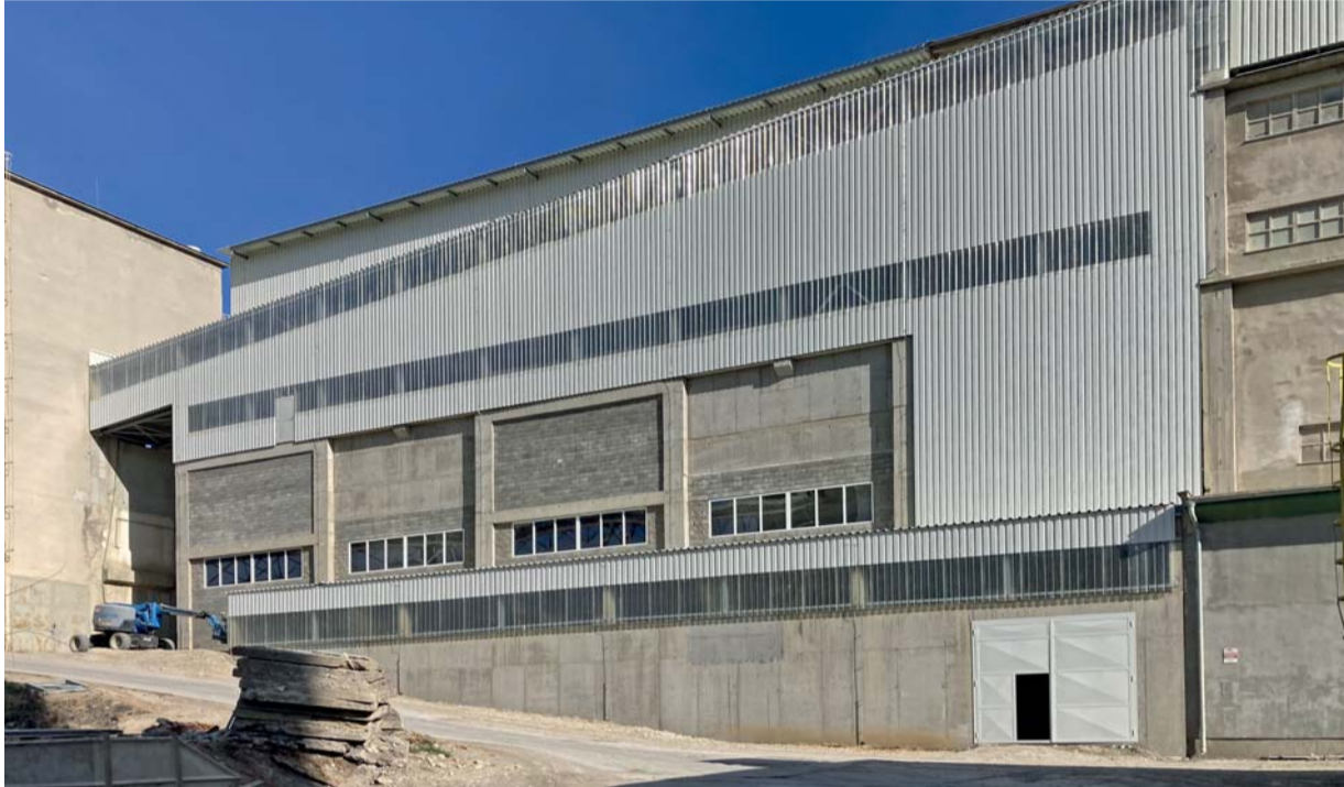
Surovinová hala Cementárny Mokrá po rekonstrukci.
