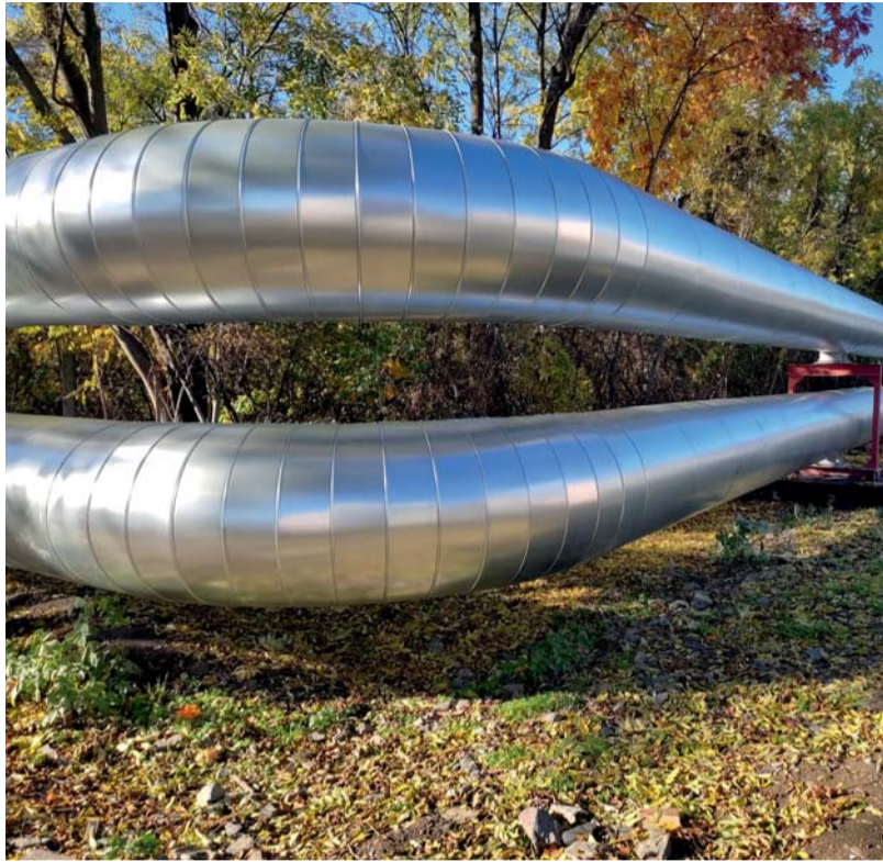
V Praze-Michli se měnilo 215 metrů izolovaného horkovodu DN700.
