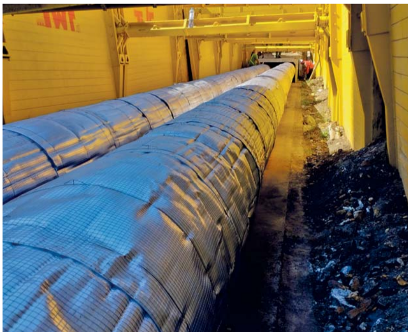
Na Střelničné se modernizoval úsek páteřního tepelného napáječe.
