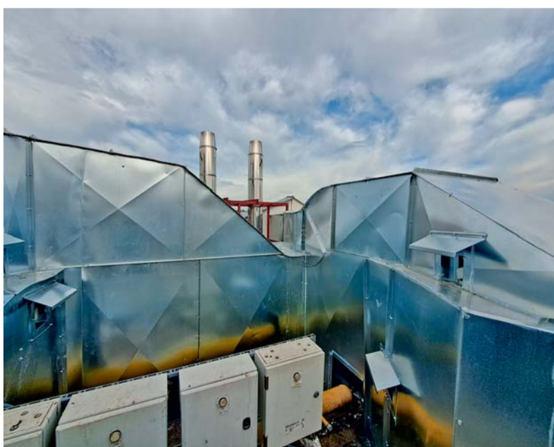
Nová tepelná izolácia s vonkajším oplechovaním a ochranou čidiel.
