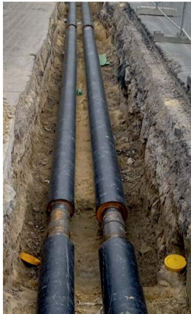
V Černokostelecké měří modernizovaný úsek horkovodu 340 metrů.
