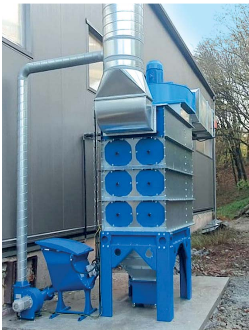
Moderní filtrační jednotky zachycují až 99,9 procent prachových částic.
