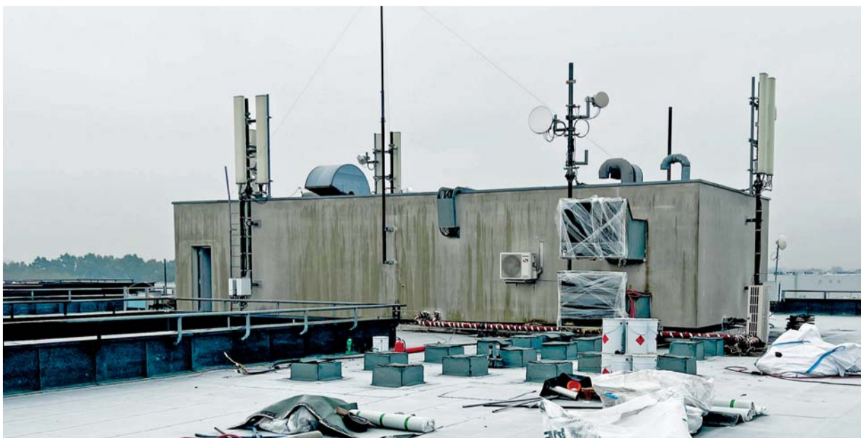
Jednotky VZT po demontáži a finálním dokončení.
