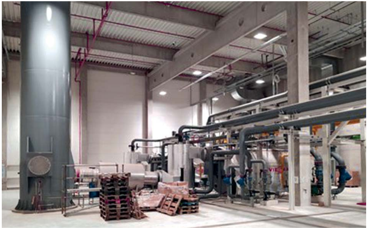
GreMi KLIMA buduje kotelnu a kompletní rozvody topení a vzduchotechniky. Dohromady jde o 39 km potrubí.
